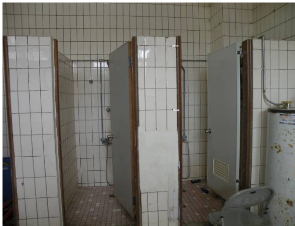
2樓男女廁內皆有淋浴間
